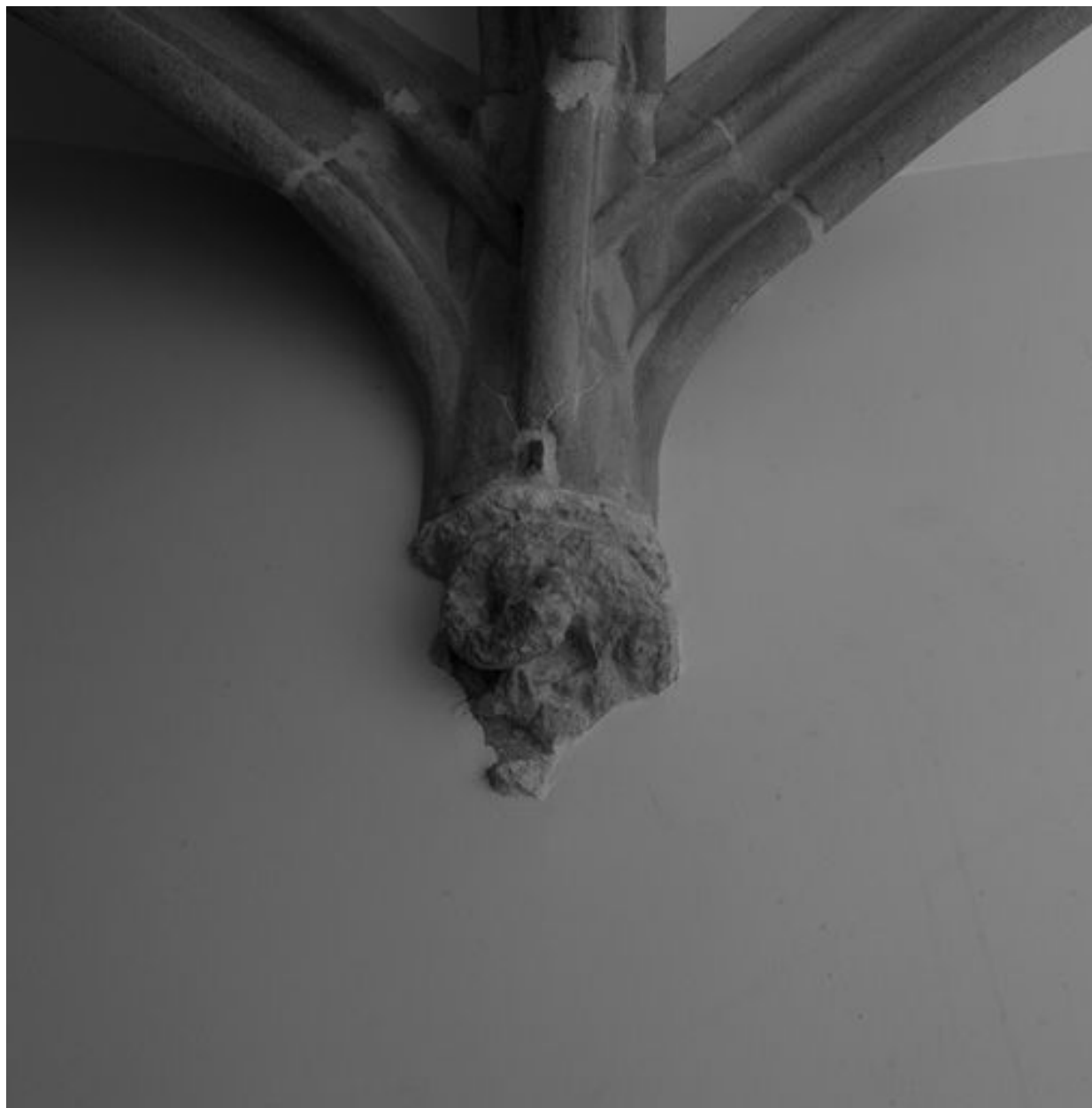
Voûte de l'allée, détail du culot 3
