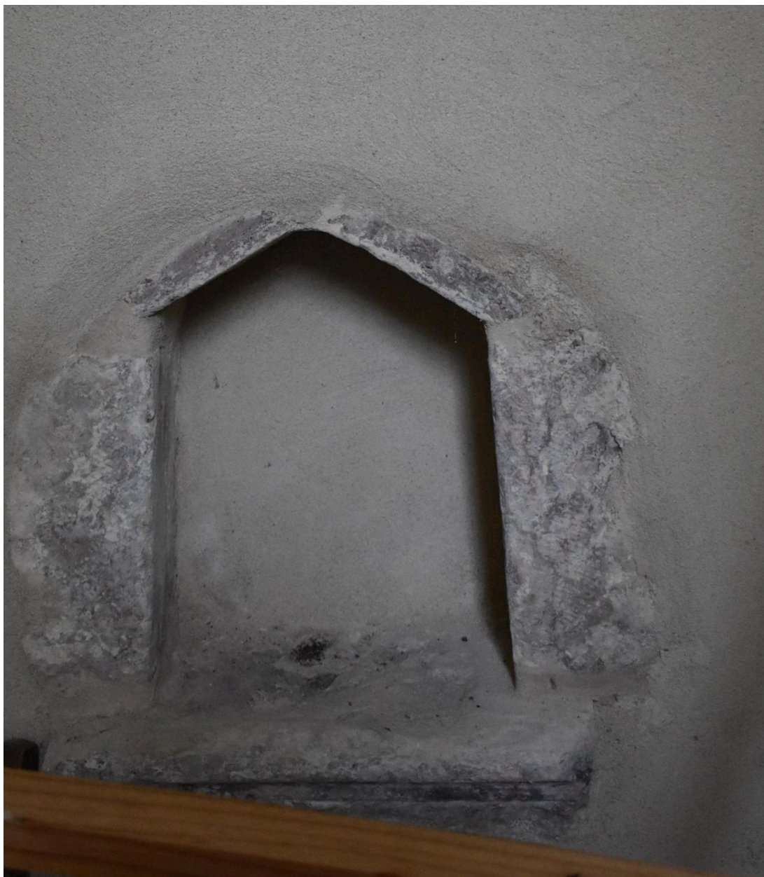
Niche-crédence, mur méridional de la chapelle.
