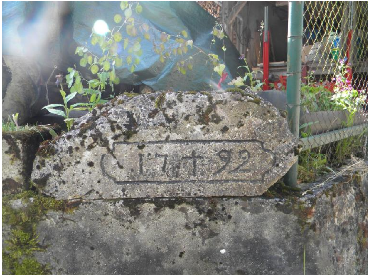
Vue d'une pierre de taille portant la date 1792 réutilisée dans un mur de soutènement.
