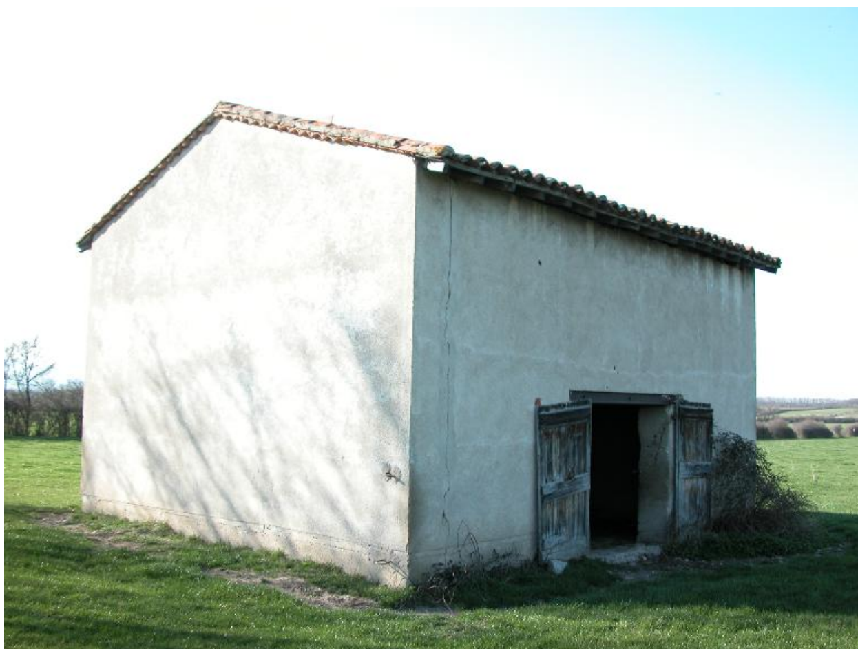
Vue d'ensemble de trois-quarts avant gauche.
