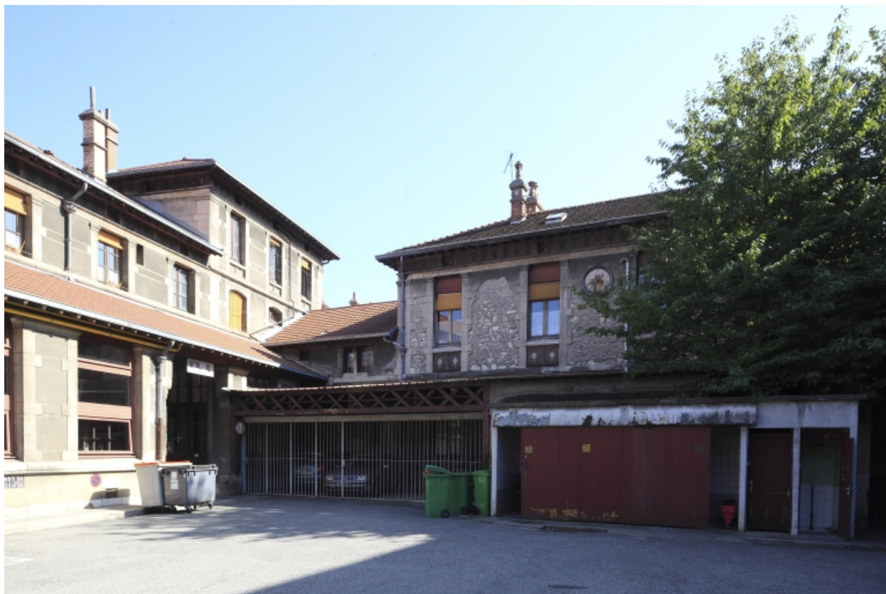
Cour E (cuisines). Au fond, bâtiment abritant des appartements de fonction.
