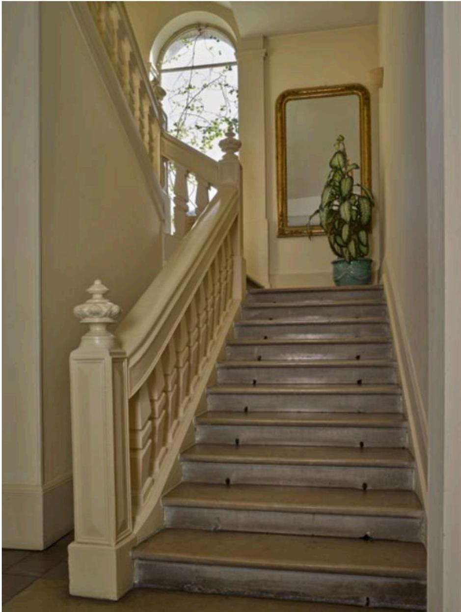
Escalier. Il s'éclaire sur l'élévation latérale sud. Il distribue tous les niveaux, y compris l'étage de comble. Il n'y a pas d'escalier de service.
