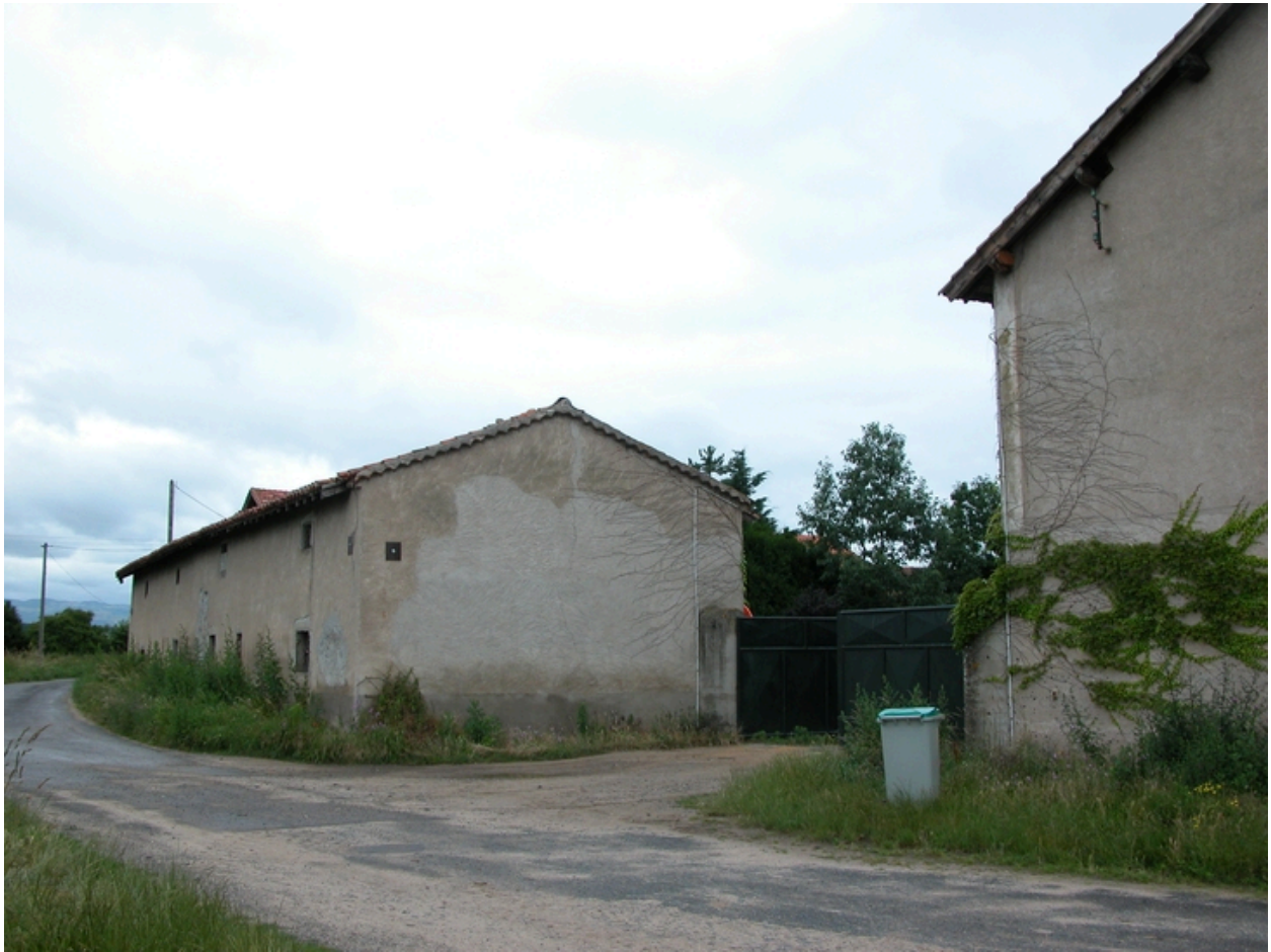
Vue du logis ancien et des étables attenantes, côté chemin.
