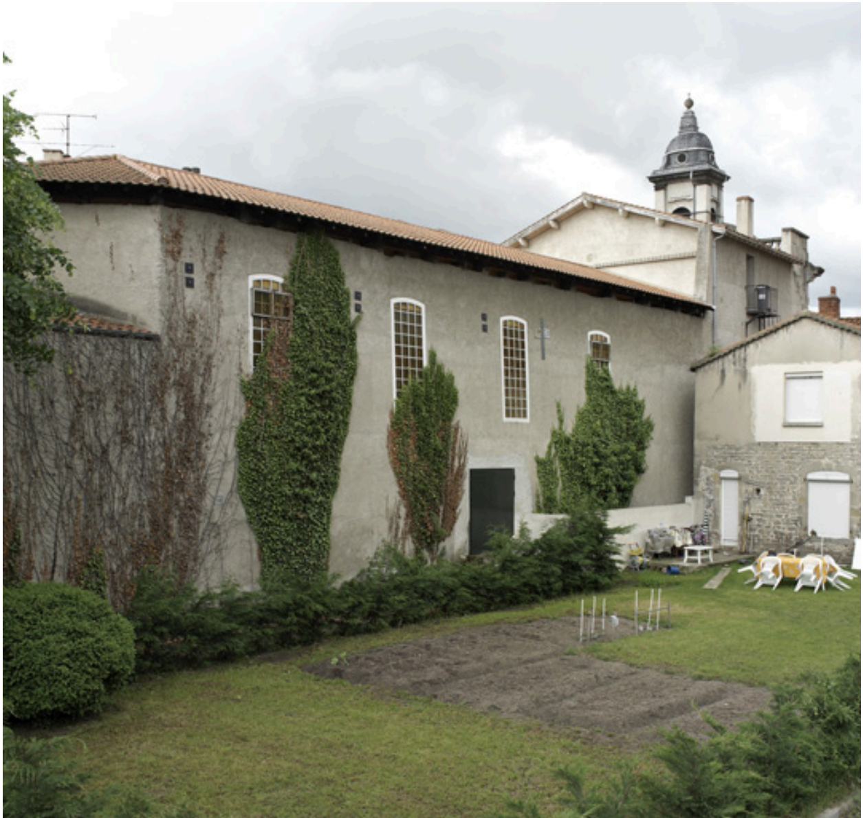
Vue de la chapelle depuis le nord-est.
