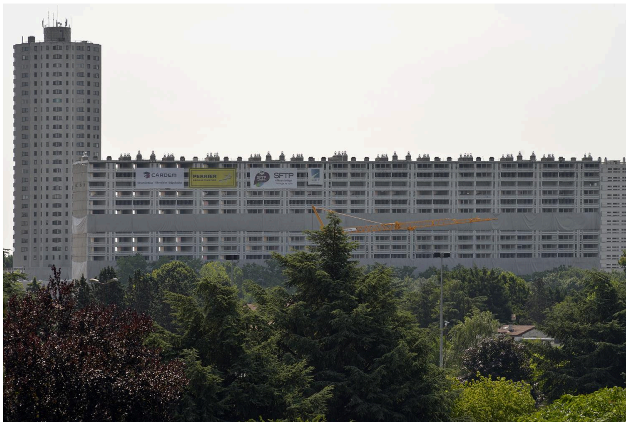
Vue d'ensemble avant démolition
