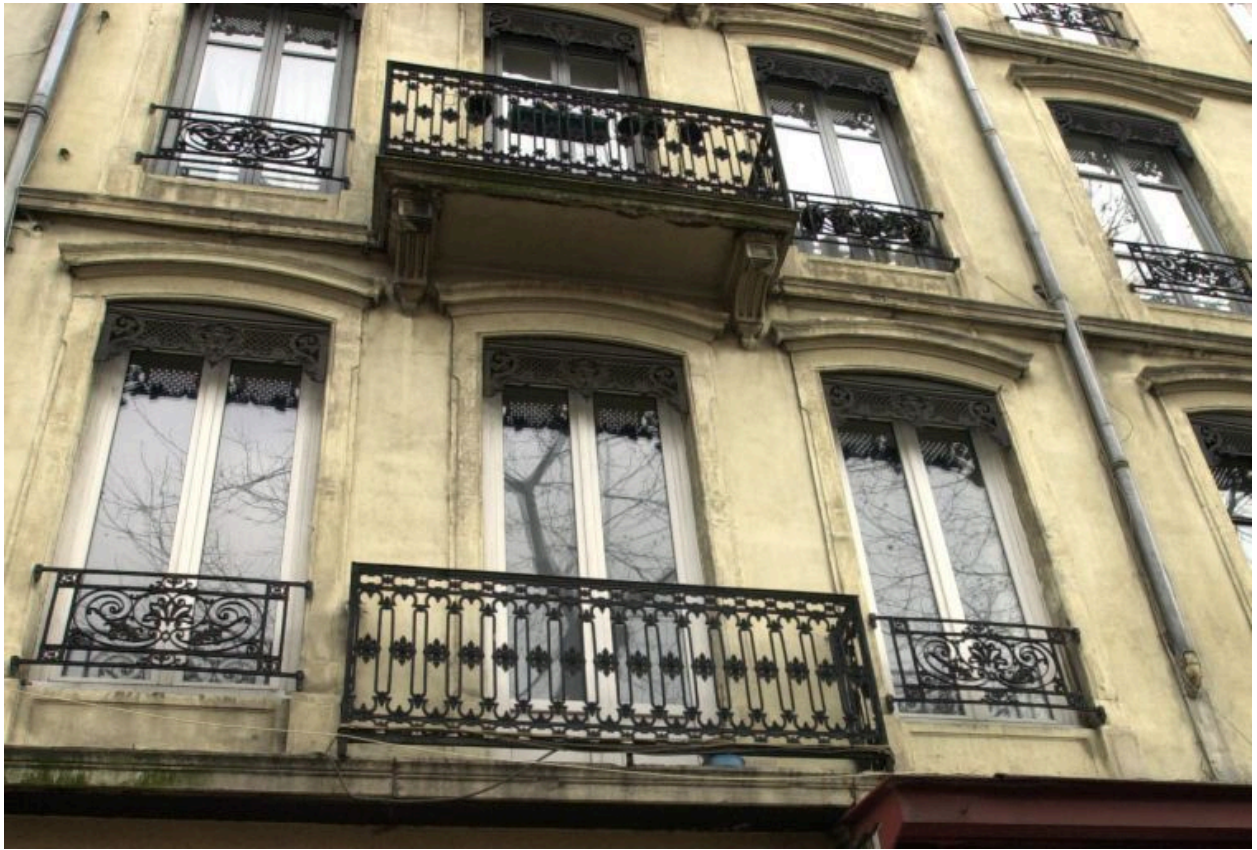
Détail des fenêtres sur rue
