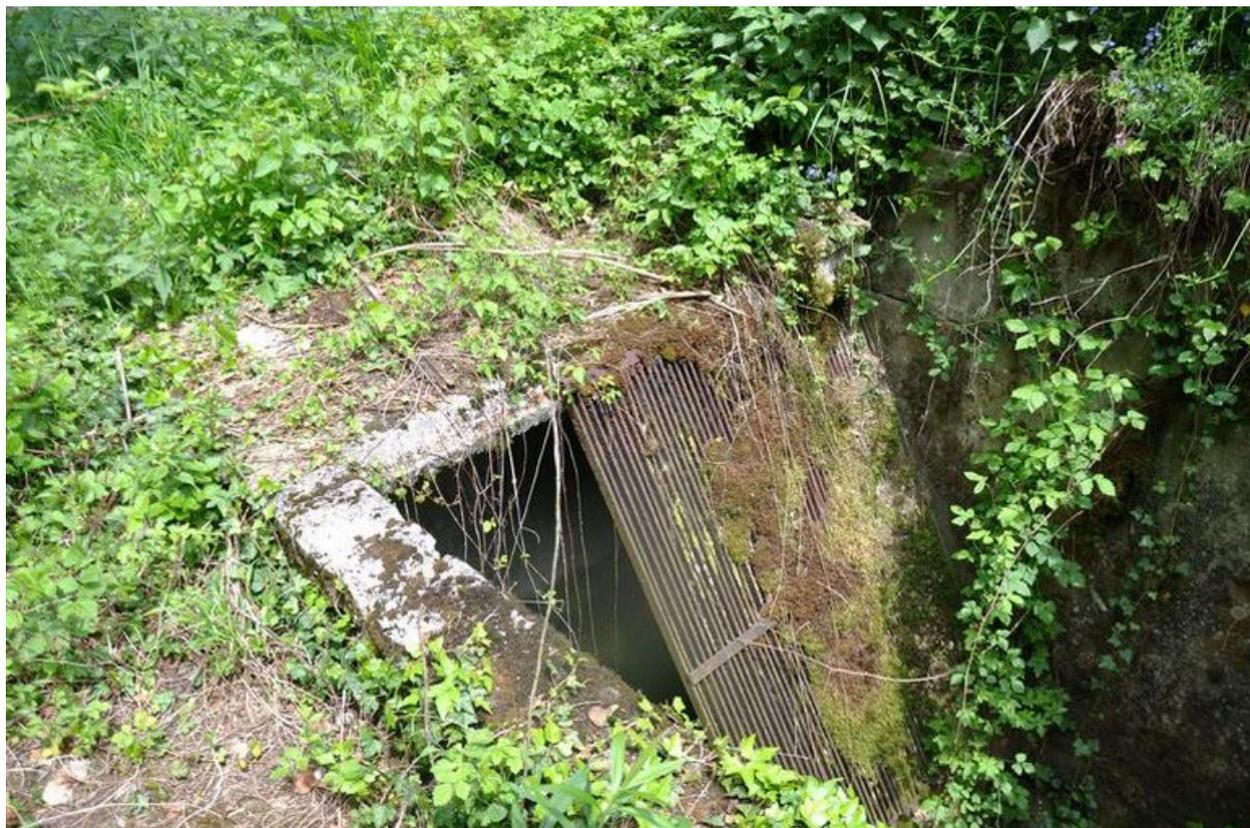
Dégrilleur du réservoir alimenté par le canal
