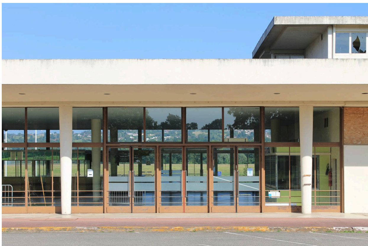
Détail de la façade ouest (côté ville) de l'aérogare de Vichy-Charmeil.
