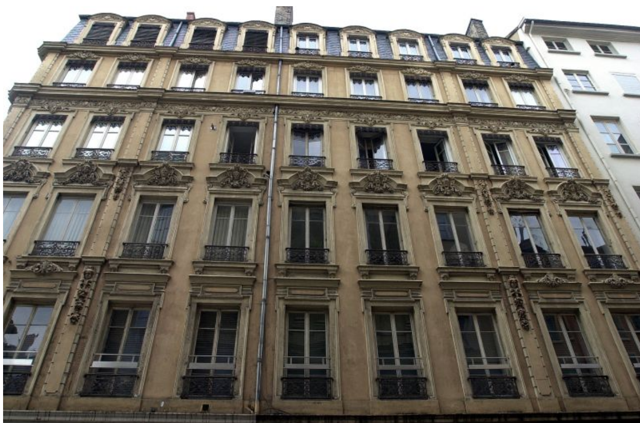
Façade sur la rue du Plâtre
