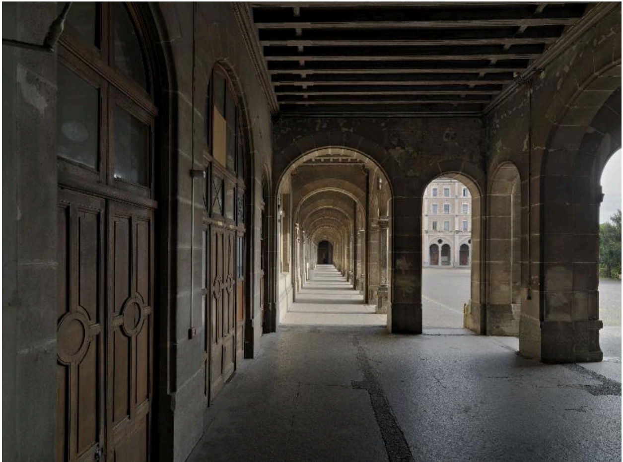
Cour, galerie nord-ouest, depuis le sud-ouest
