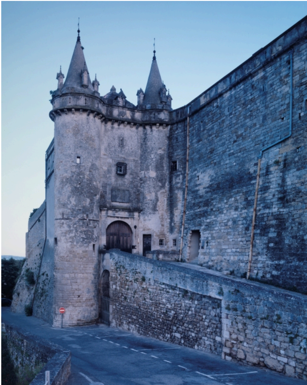
Bâtiment d'entrée. Vue générale prise depuis la Planette.
