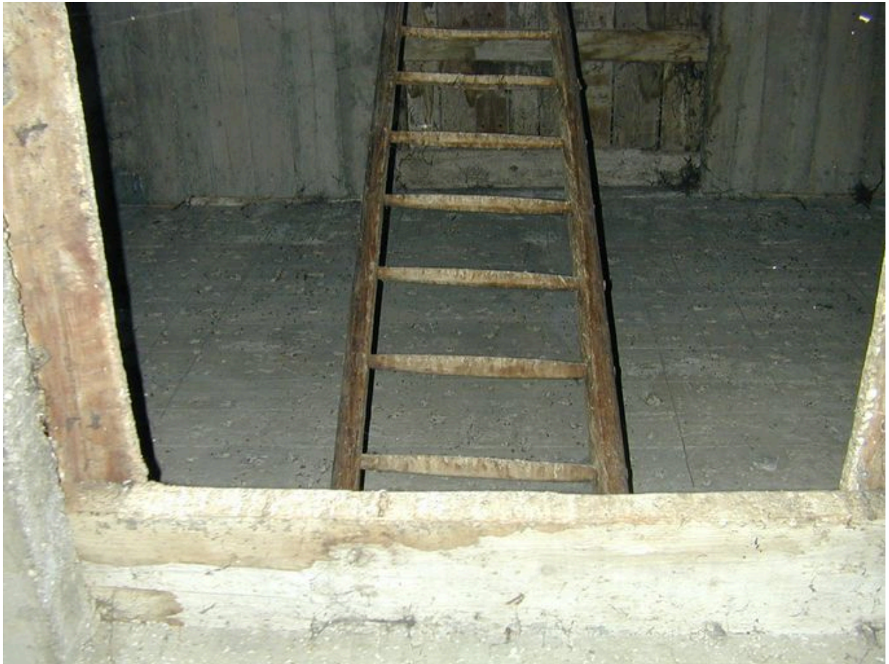
Echelle d'accès au sommet du clocher depuis le 2e niveau
