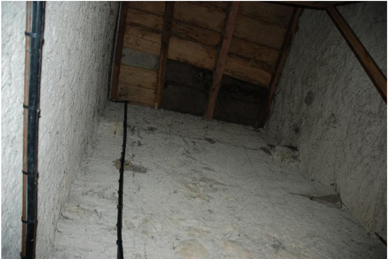
Vue d'ensemble intérieure du clocher et de son échelle d'accès à la chambre des cloches.
