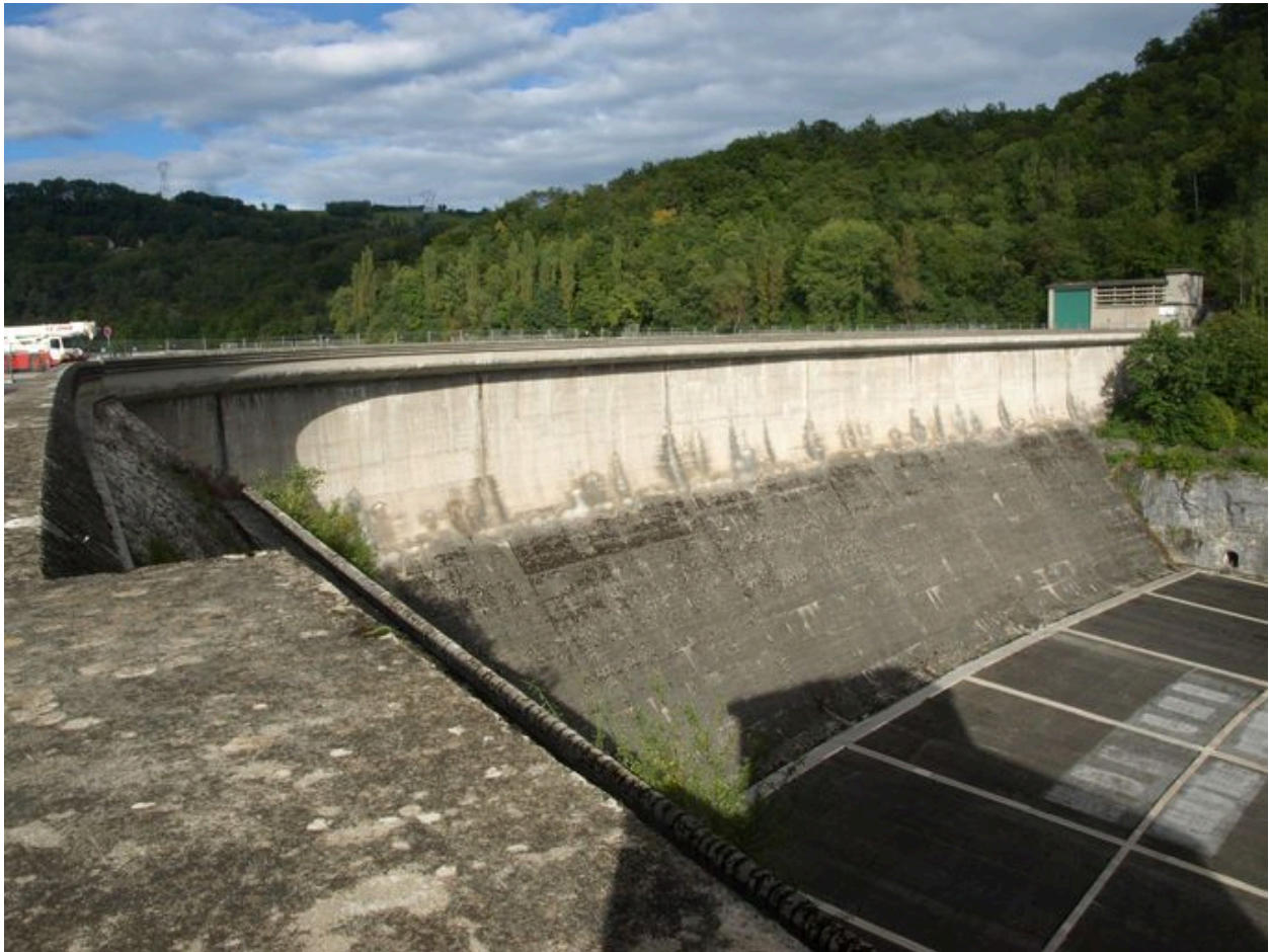
Vue générale du pont amont du barrage, face aval (depuis la rive droite)
