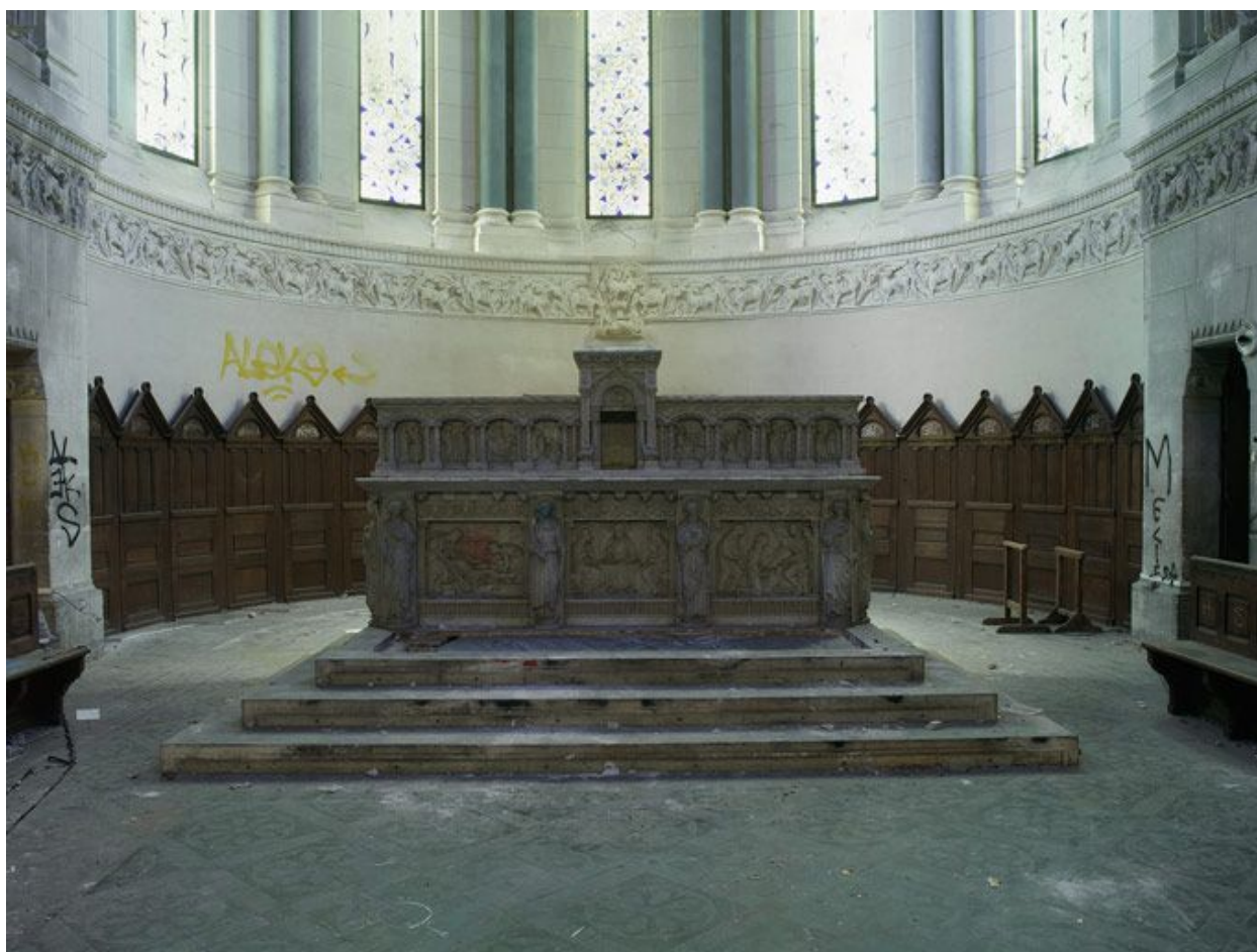
Vue des lambris de demi-revêtement derrière le maître-autel, en juillet 2011.
