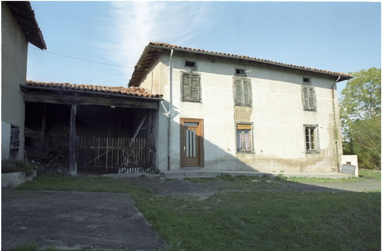
Ailleux, Croix-Lestra (1987 A3 323), type B2. Vue d'ensemble du logis et du hangar.
