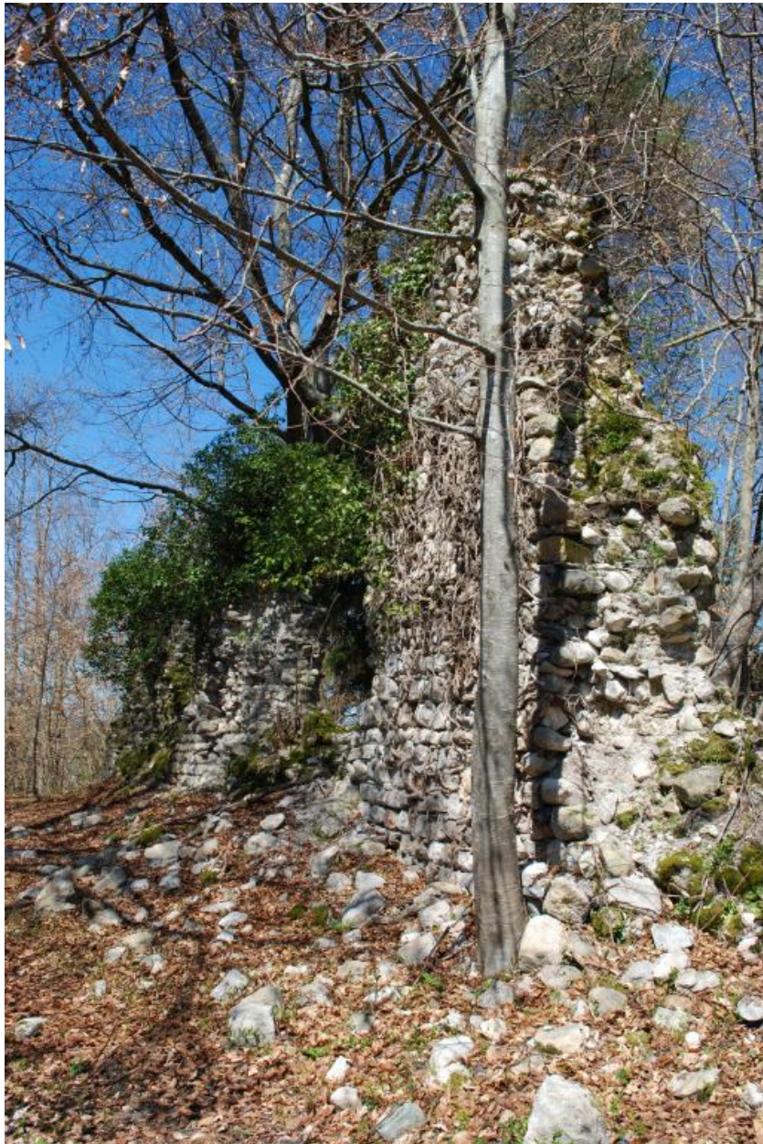
Château, élévation extérieure des murs en ruine situés au sud-ouest.
