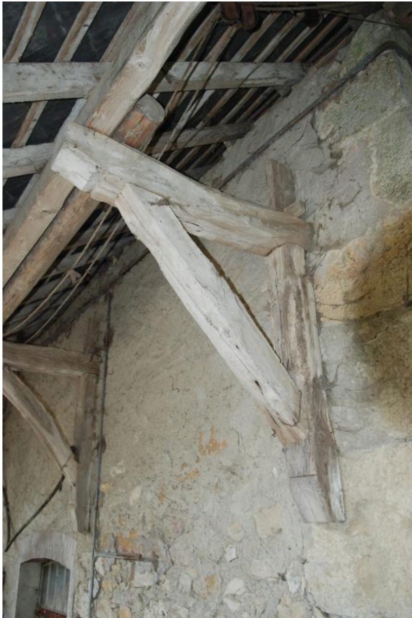
Détail des aisseillers soutenant la toiture de la grange-étable ouest.
