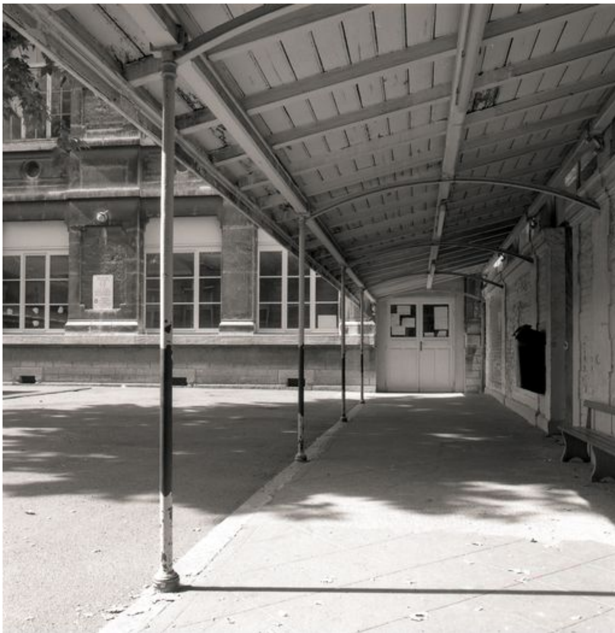
Ecole maternelle. Passage côté ouest, avec toit en zinc soutenu par des colonnes en fonte
