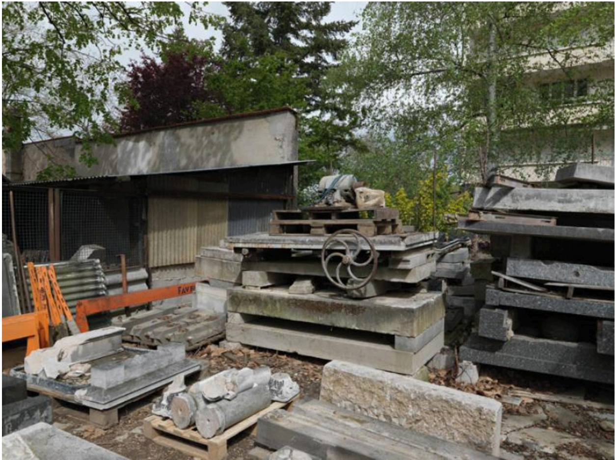
La cour, stock de matériaux et chariot pour débituse
