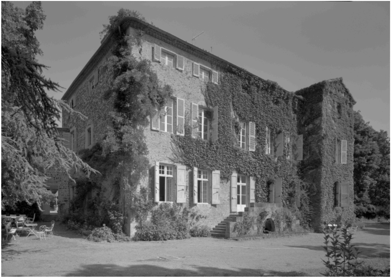
Vue d'ensemble de la façade postérieure, de trois-quarts gauche.
