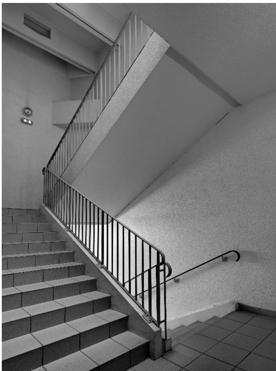
Bâtiment A : escalier secondaire rampe sur rampe
