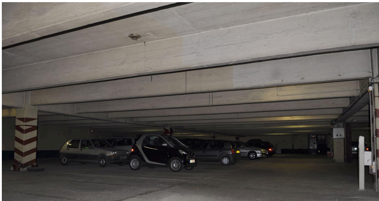
Vue intérieure du parking souterrain
