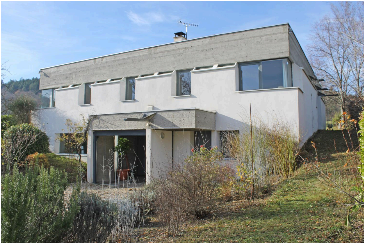
Romagnat, la Maison R., la façade principale vue du nord-est.
