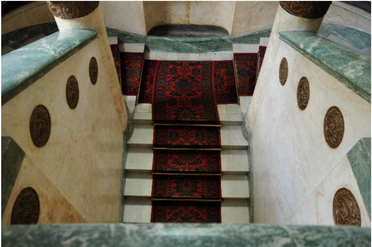
Détail de l'escalier
