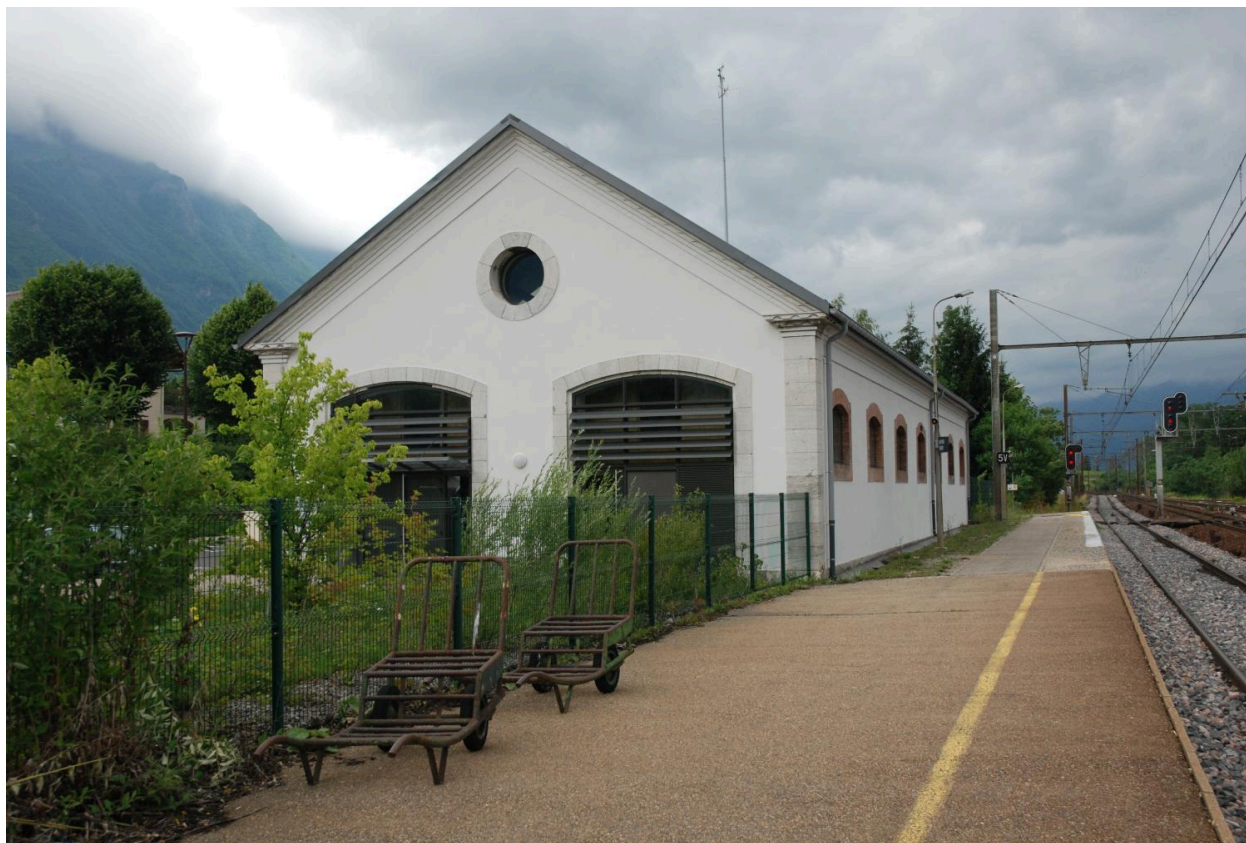
Gare de Saint-Pierre-d'Albigny : la remise à voitures.
