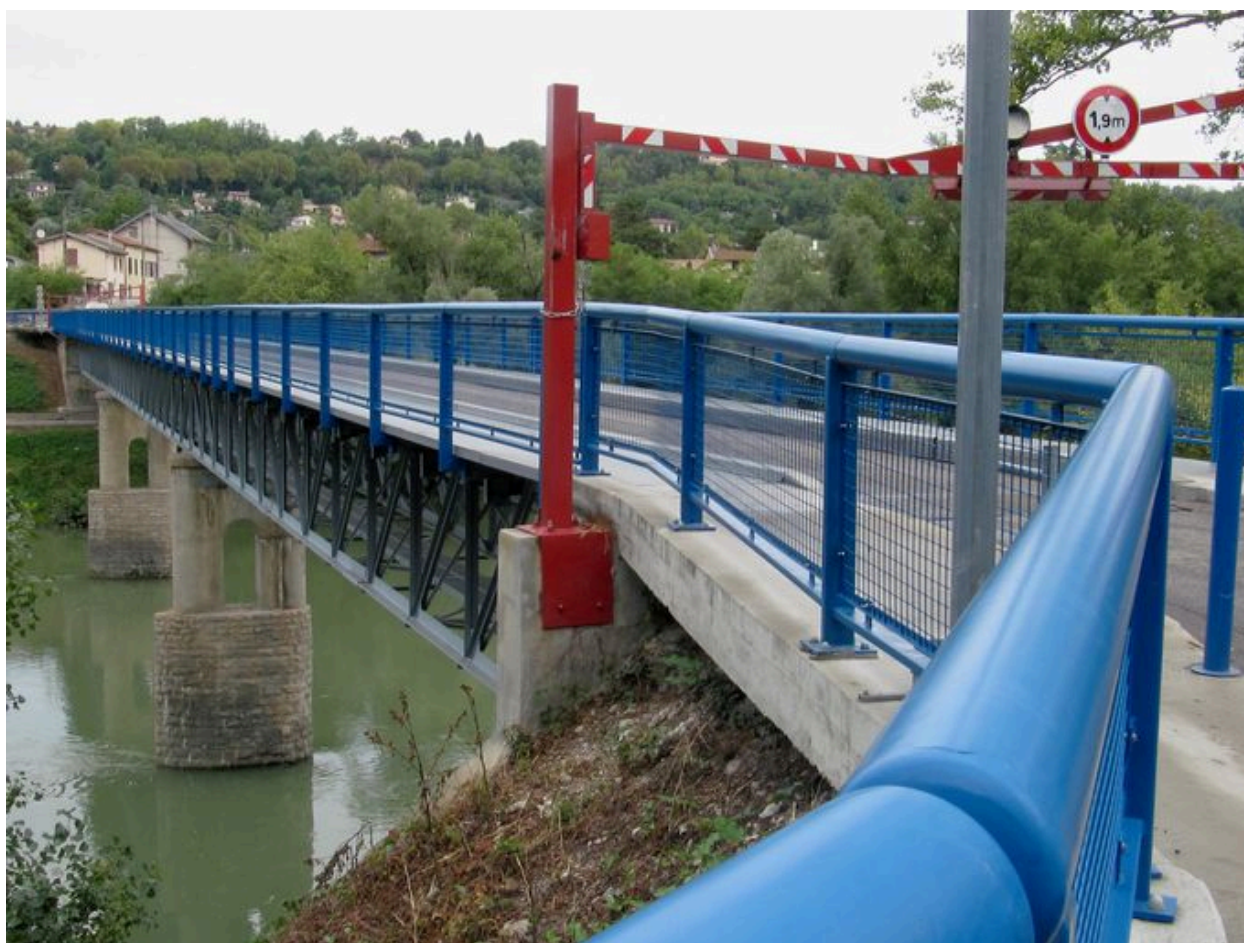
Garde-corps, face aval (depuis la rive gauche)
