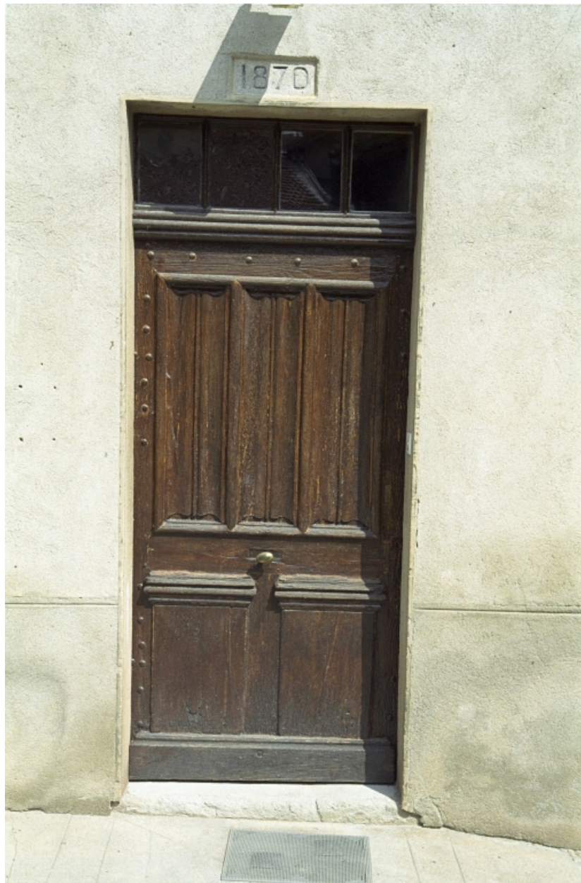
Ferme (A2 620, 622, 623), détail de la porte d'entrée.
