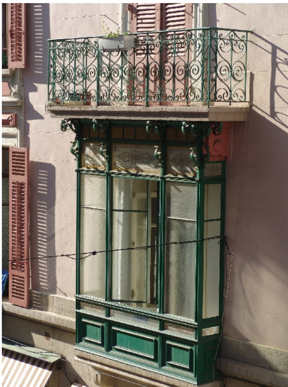
Détail de la façade
