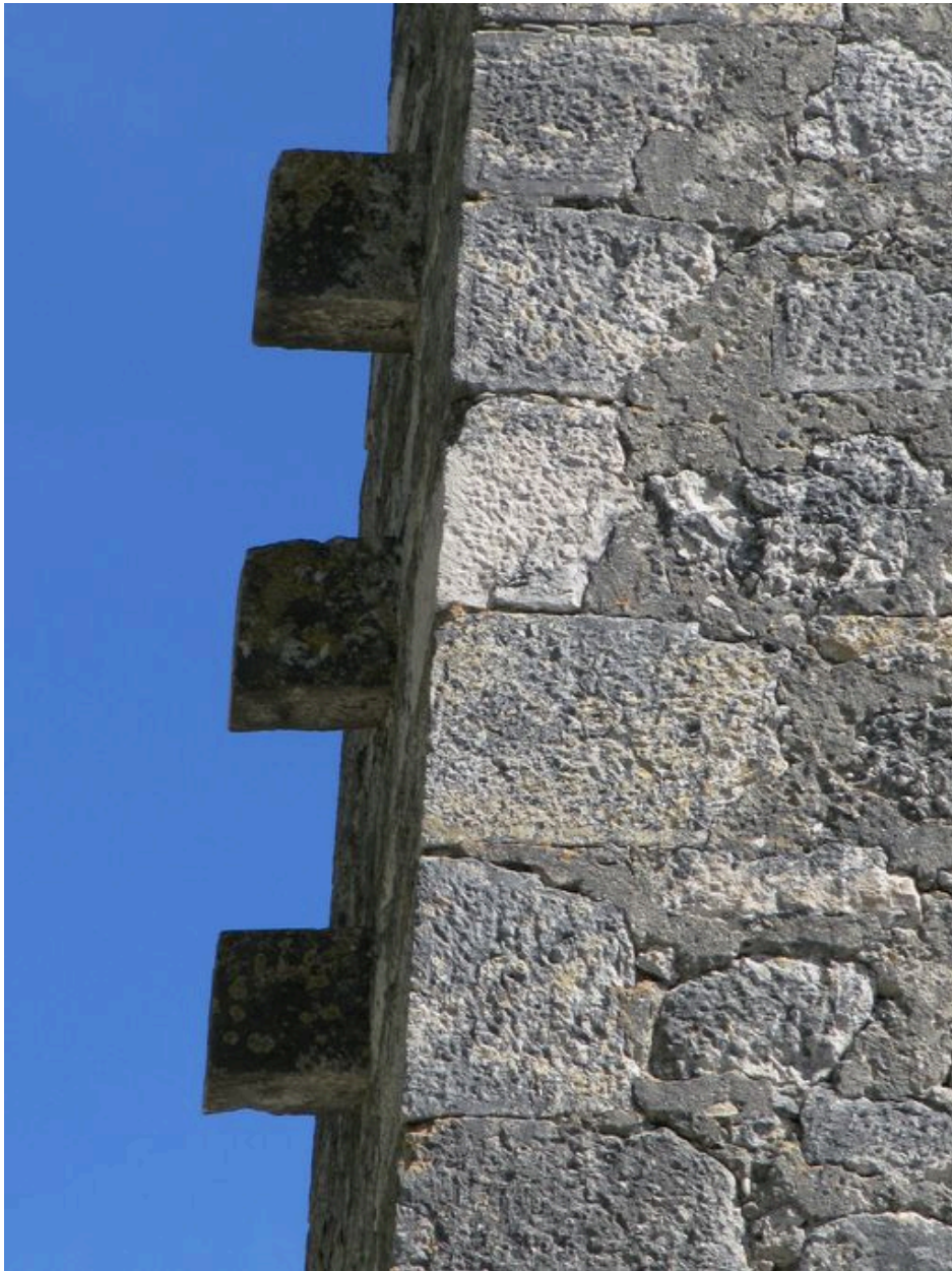
Vue partielle de la pile, escalier (angle sud-ouest)
