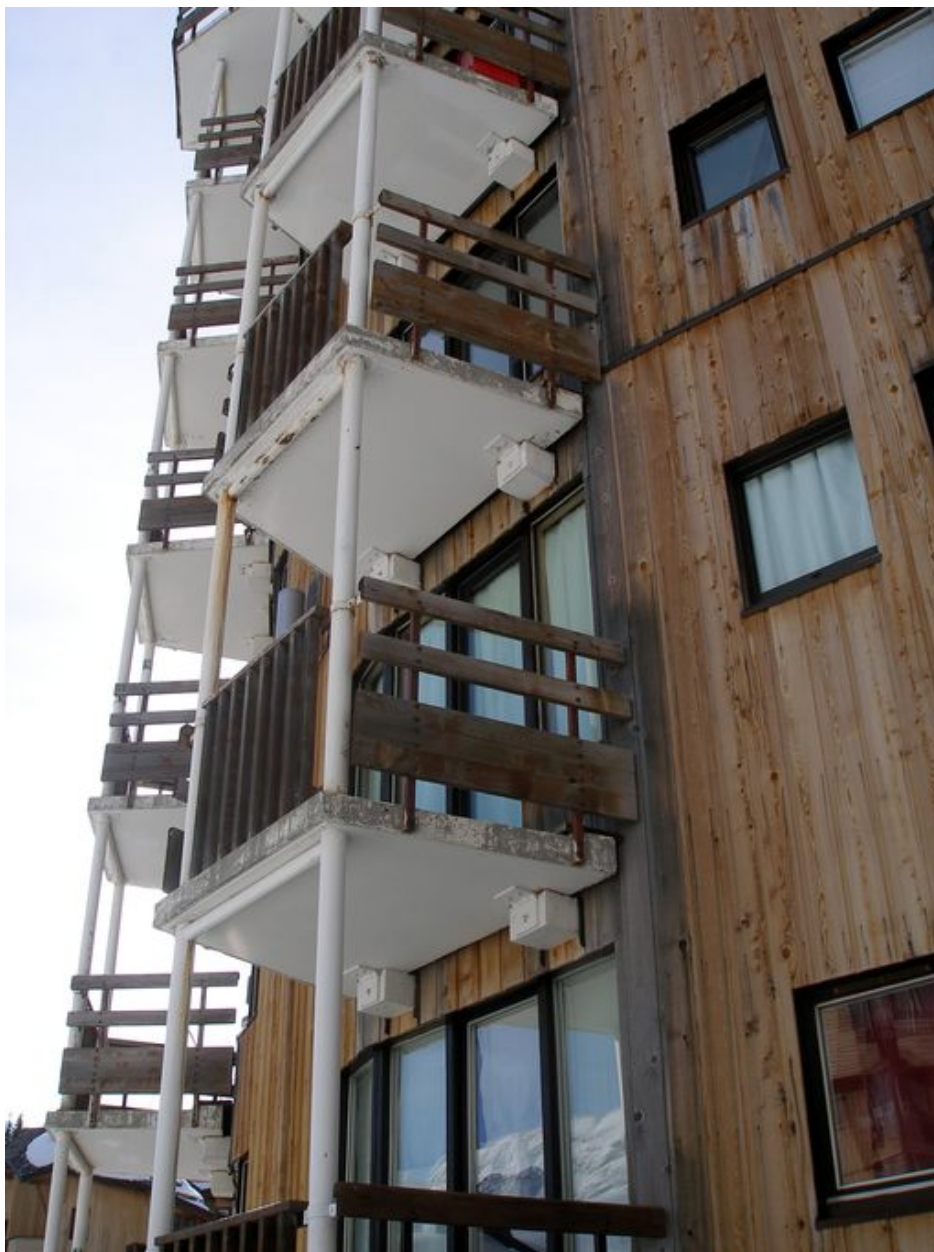
Détail des balcons, façade sud
