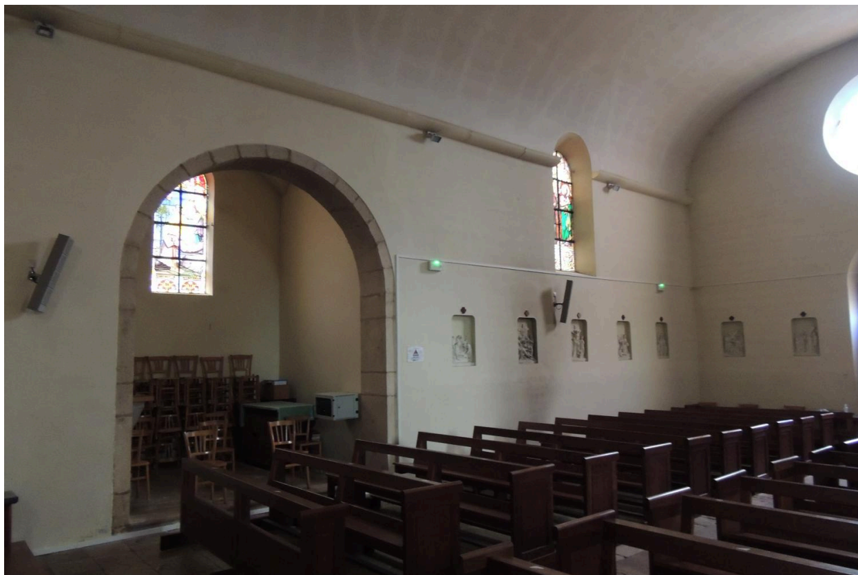
Vue intérieure, élévation sud.
