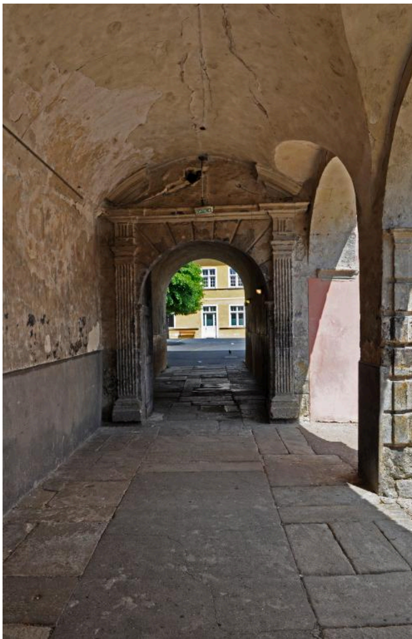
Bâtiment B : portique, passage vers la cour 2
