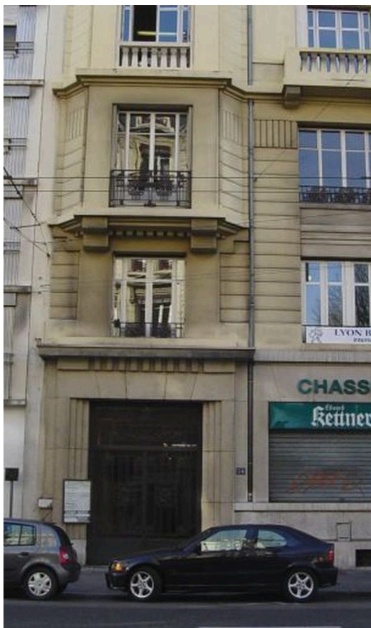
Porte d'entrée cours Lafayette
