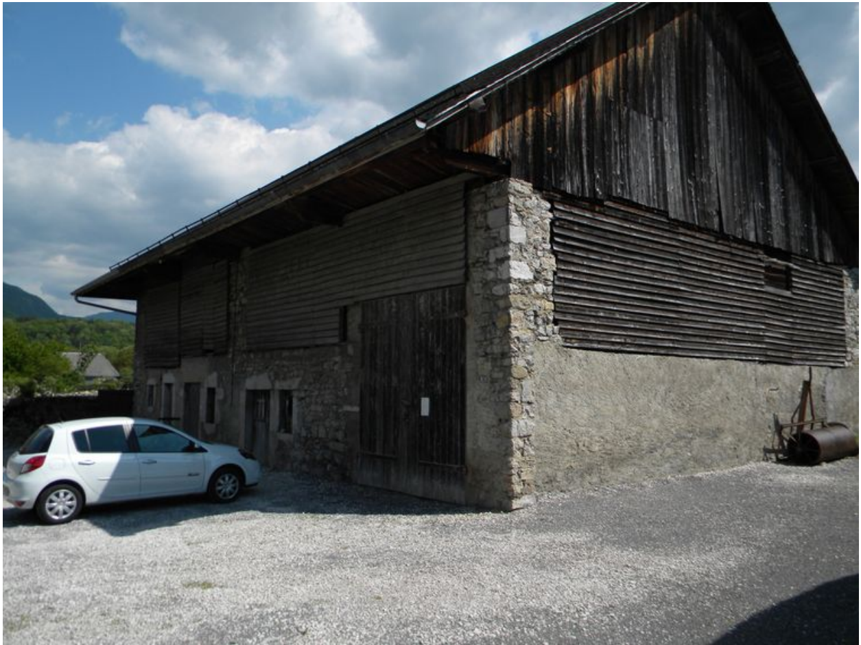
Vue générale avec mur pignon ouest aveugle au premier plan.
