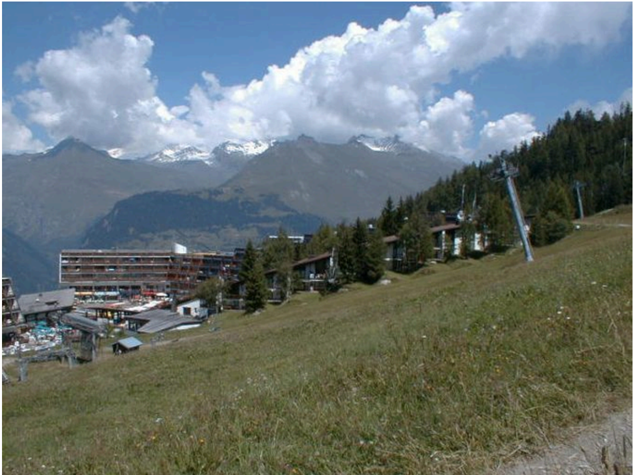
Vue depuis le sud
