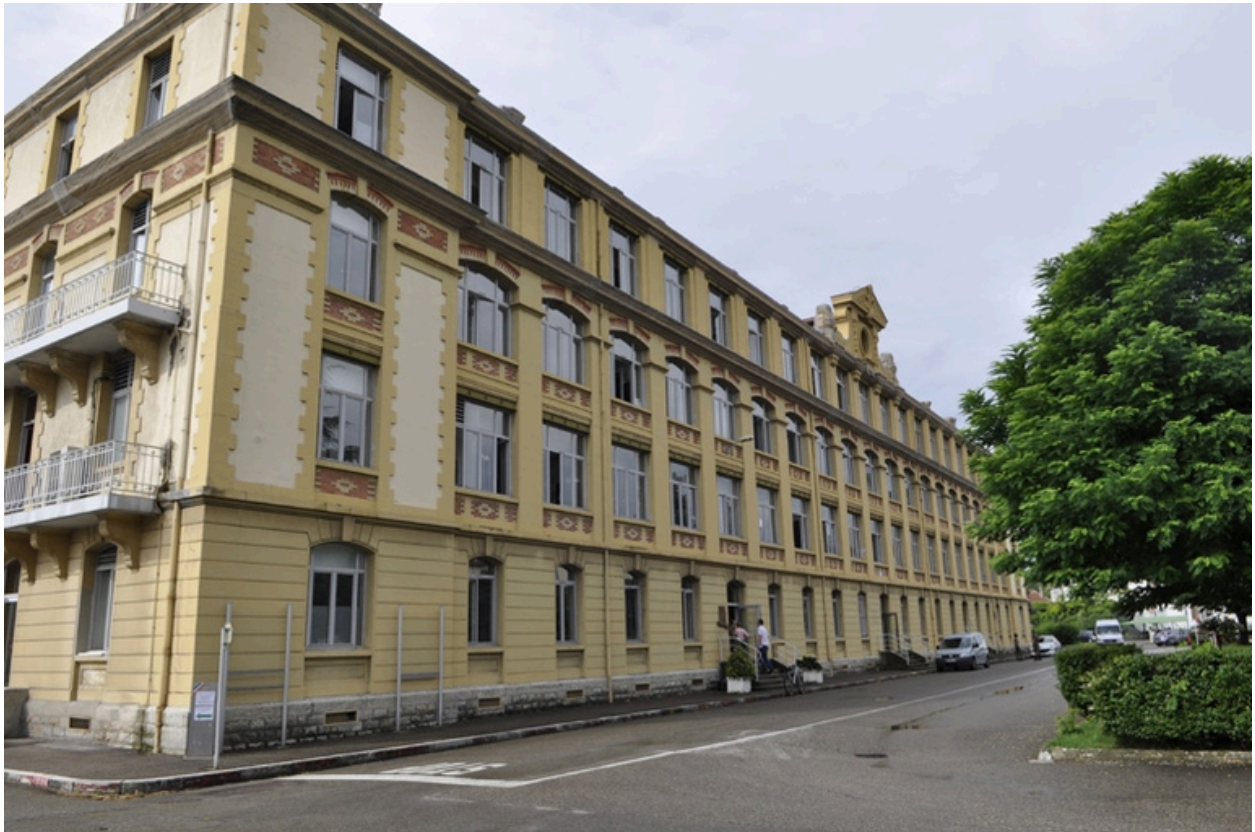
Bâtiment de 1916, vue de la façade nord.
