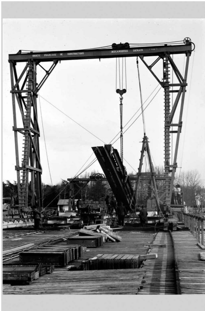
La construction du pont de la Boucle. la pose des poutrelles des arches supérieures. Photogr., [1903] (Arch. mun. Lyon. 15 Ph 1817)
