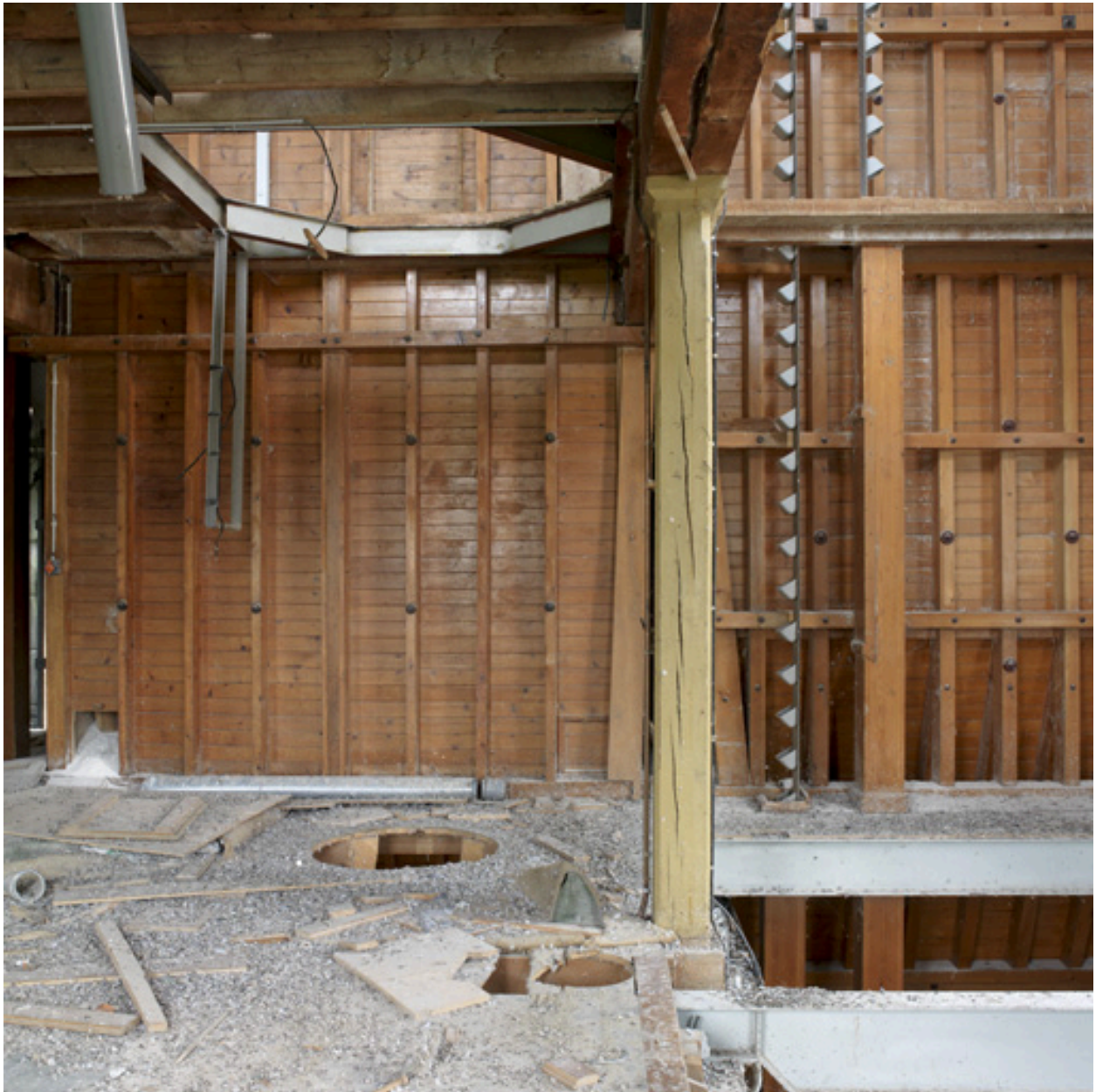
Vue intérieure du bâtiment de production : élévateur à godets.
