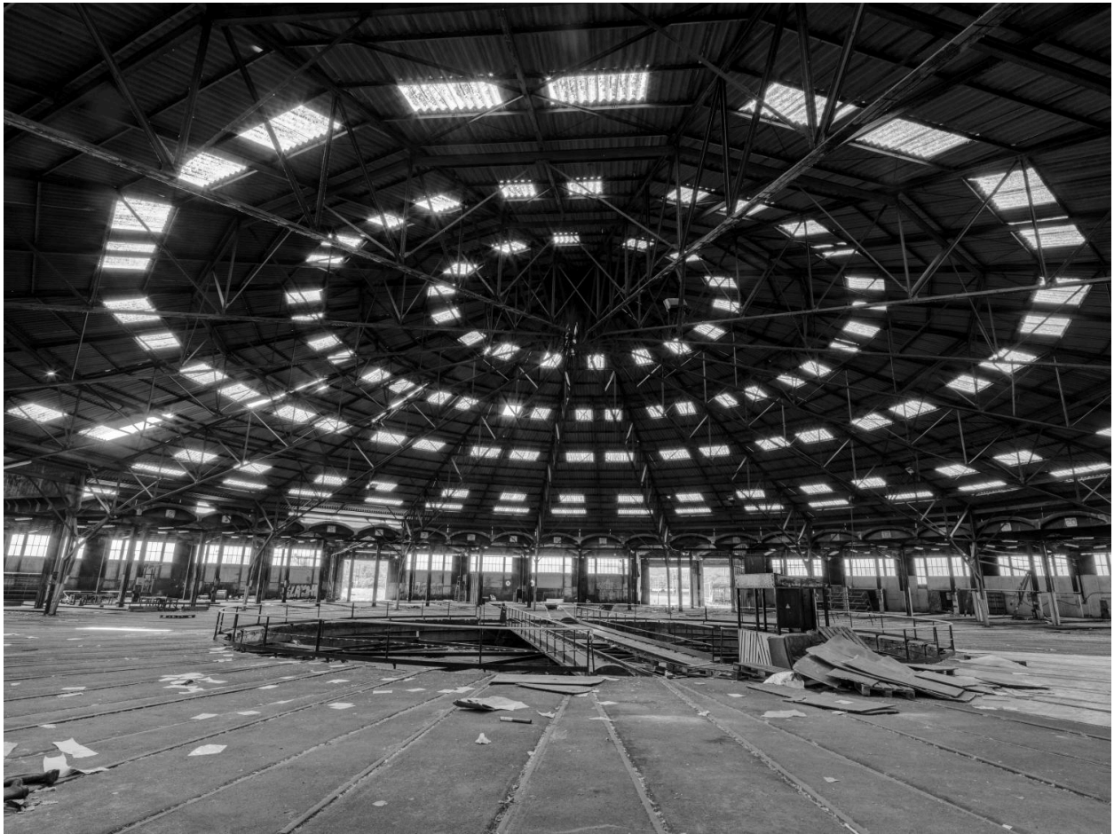
Vue centrale et pont roulant de la rotonde
