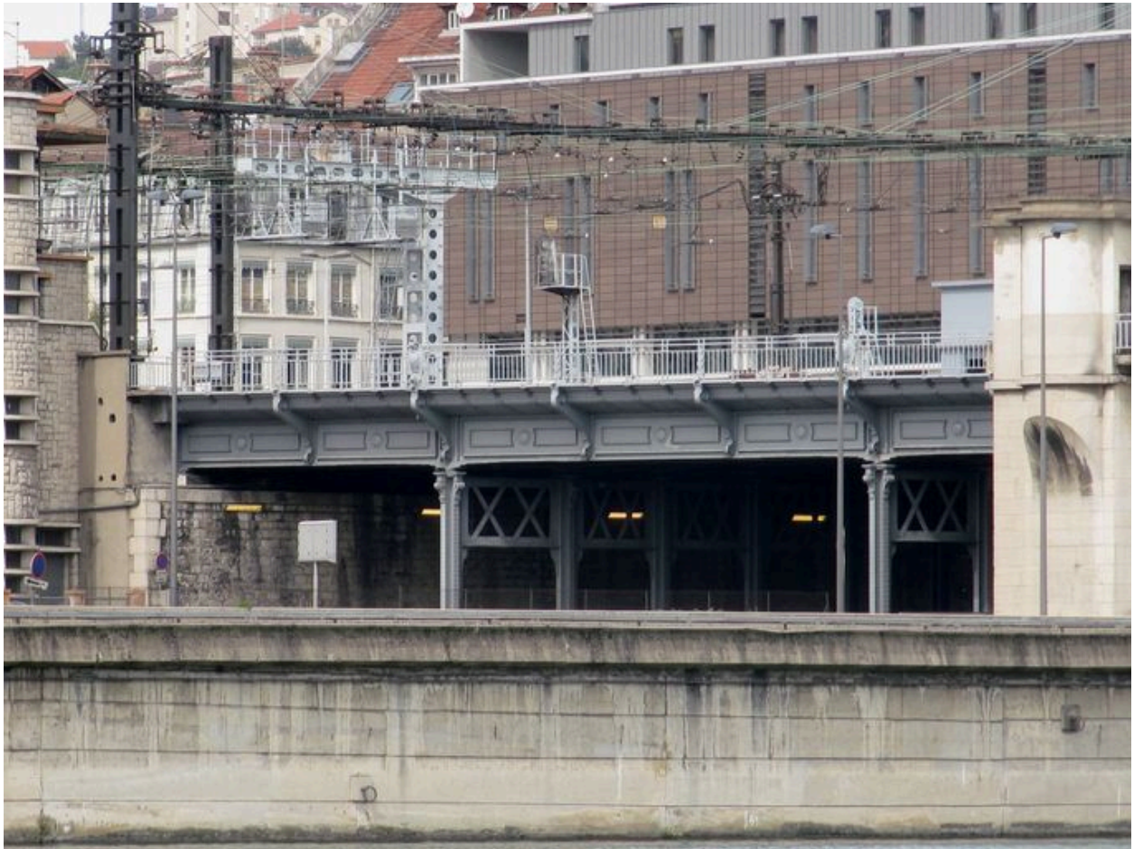
Travée de rive droite, face aval, vue générale (depuis la rive gauche)
