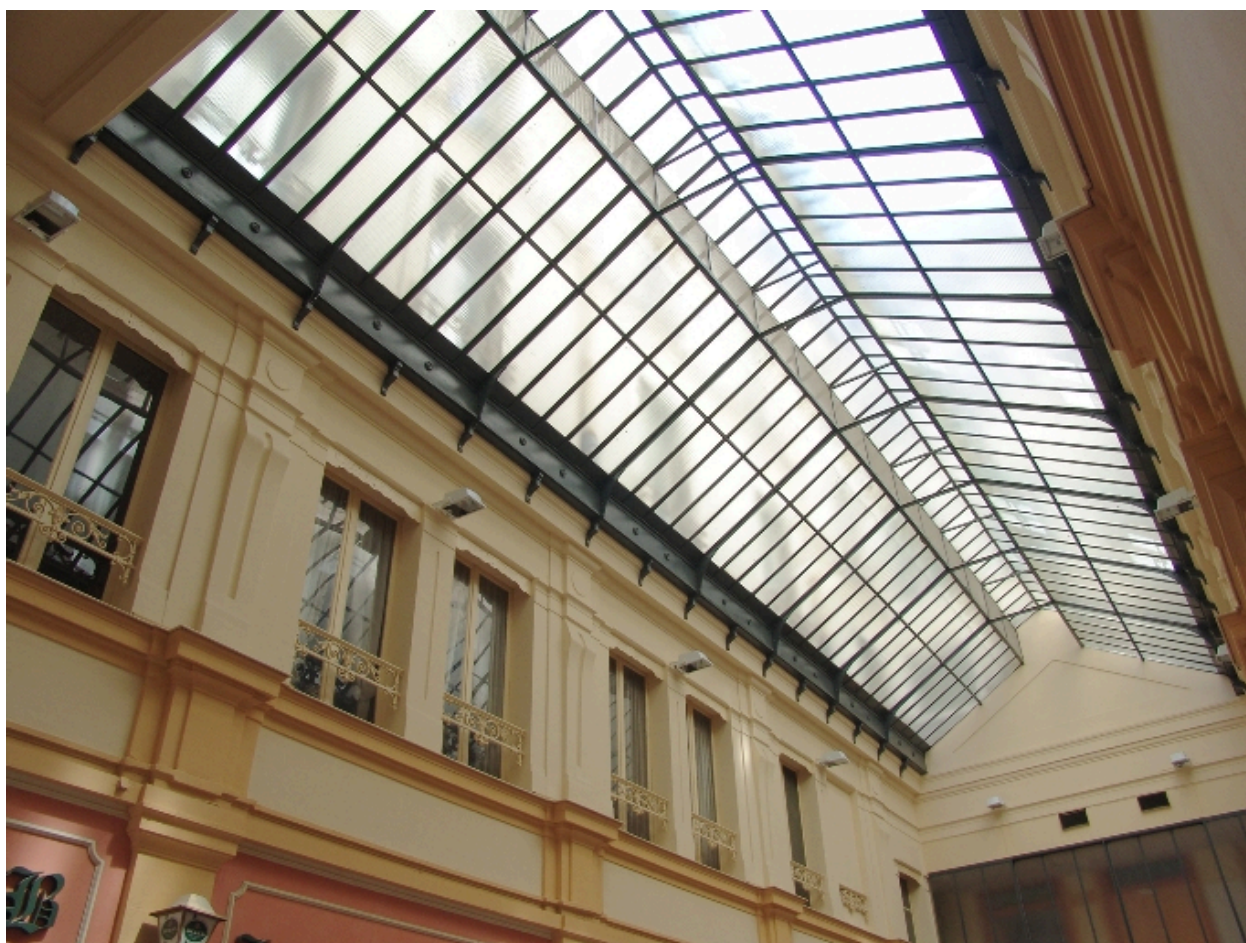
Verrière couvrant le passage
