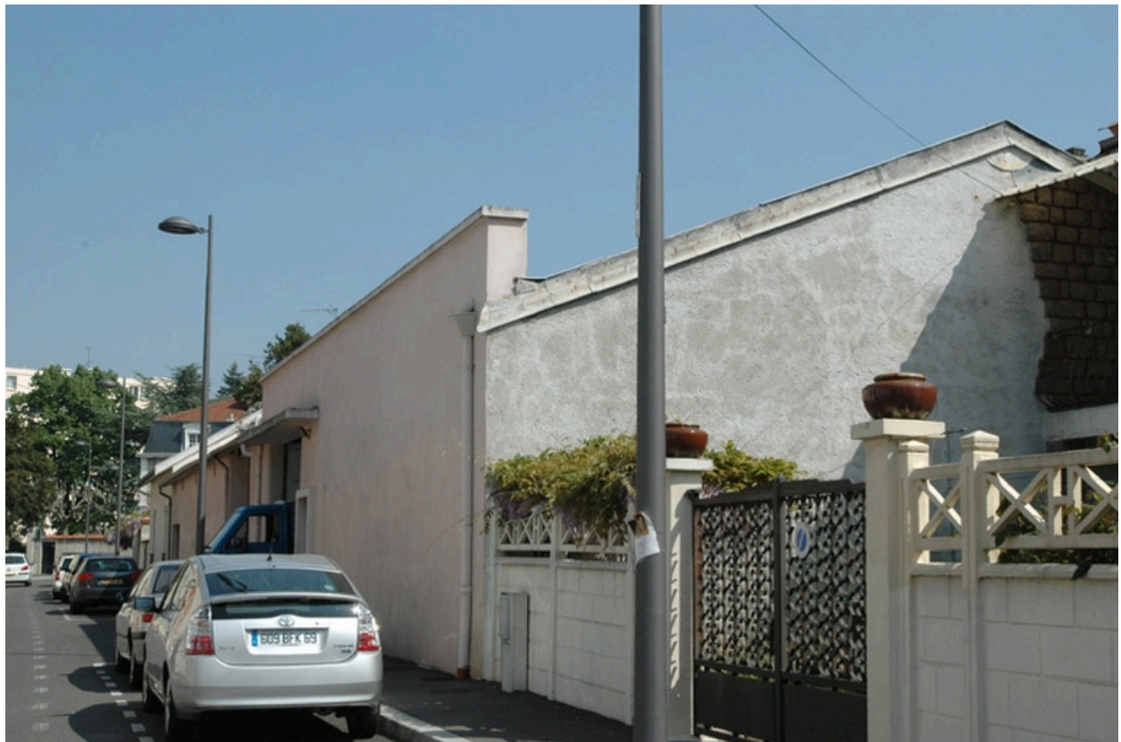
Vue générale. Façade principale, vue sud.
