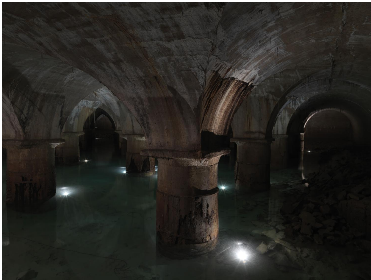
Détail pilier bassins filtrants
