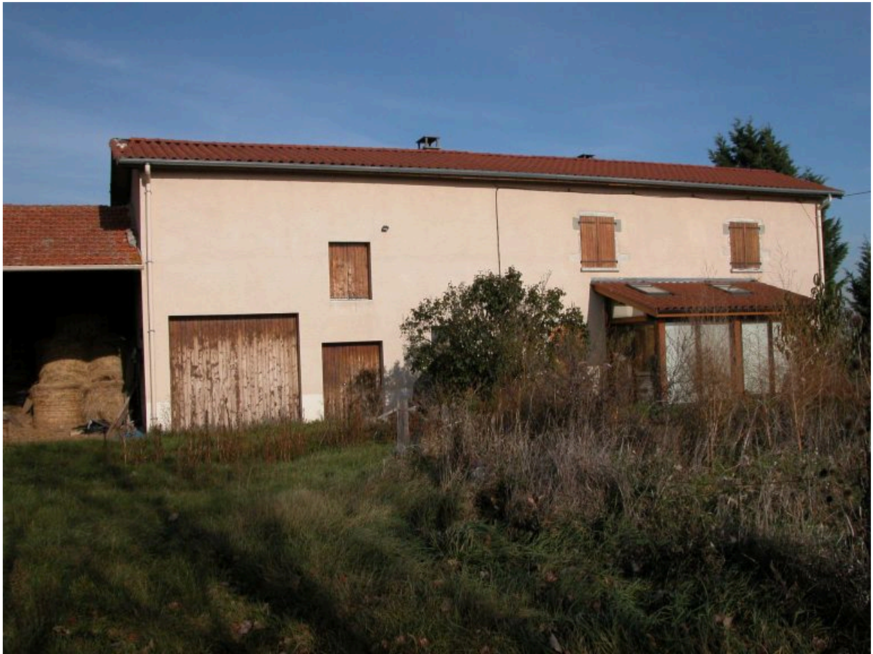
Vue générale du logis et de la grange-étable.
