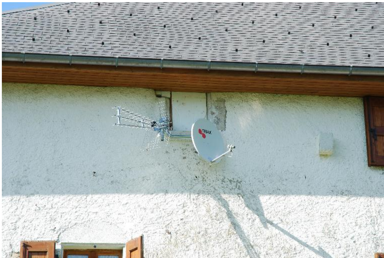
Façade sud, baie chanfreinée de l'étage carré.
